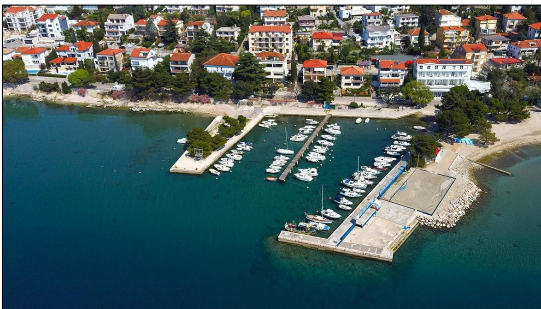
Slika 2. Postojeće stanje luke Črni mul (Izvor: www.zlu-cr-ikvenica.hr )
