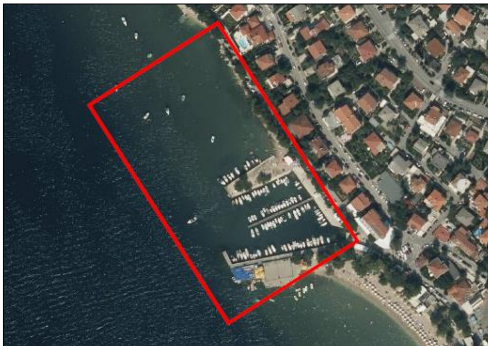
Slika 1. Ortofoto snimak luke Črni mul u postojećem stanju, te približno označen obuhvat zahvata (crvenom bojom)
